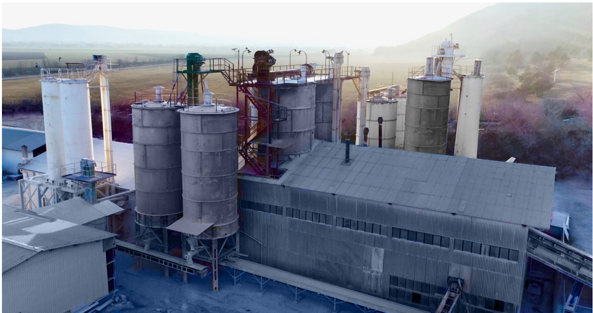
Drvenie vápennej múčky v ocelových zásobníkoch
