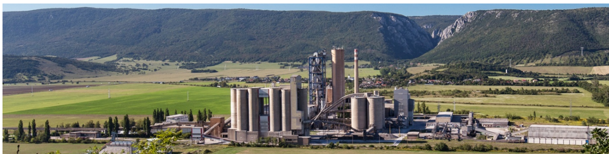
Pohľad na cementárne kazí nerušený výhľad na Zádielsku tiesňavu Zdroj: internet
